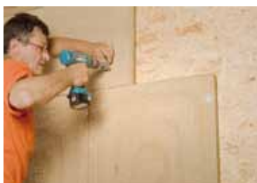
Wandheizungsplatten aus Lehm und Lehm- bauplatten ohne Rohr bekleiden die gesamte Wand und werden zuletzt mit einer dünnen Schicht Lehm abgspachtelt.
