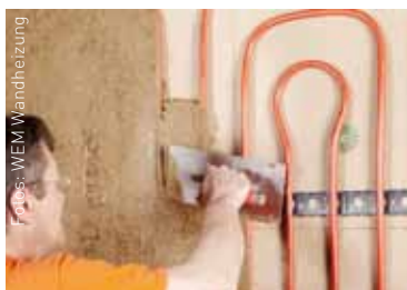
Klimaregister werden an der Wand befestigt und mit Lehm oder Kalk eingeputzt.
