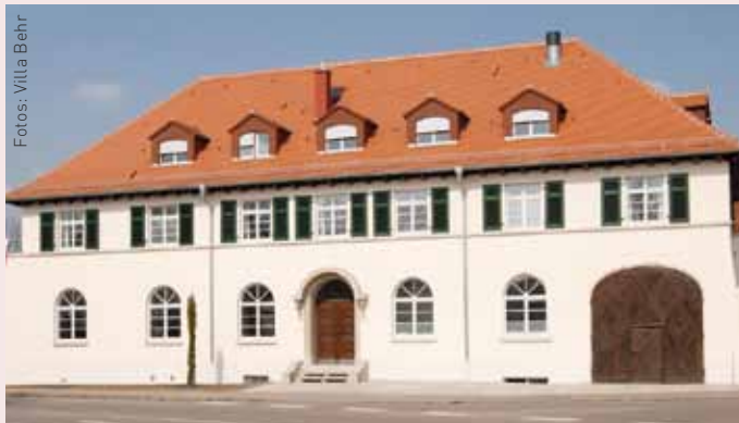
Die ehemalige Kantine einer Möbelfabrik steht unter Denkmalschutz und erstrahlt nach einer Komplettsanierung in neuem Glanz.
